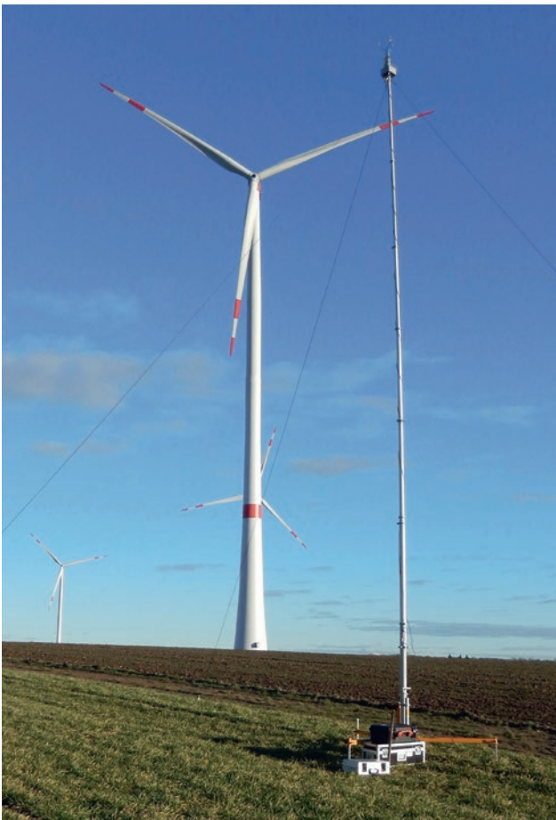
Abbildung 4.6-1: Windenergieanlage WEA 5 mit landwirtschaftlich genutztem Umfeld. Im Vordergrund erkennt man den 10 m hohen Windmessmast. Foto: Fa. Wölfel
