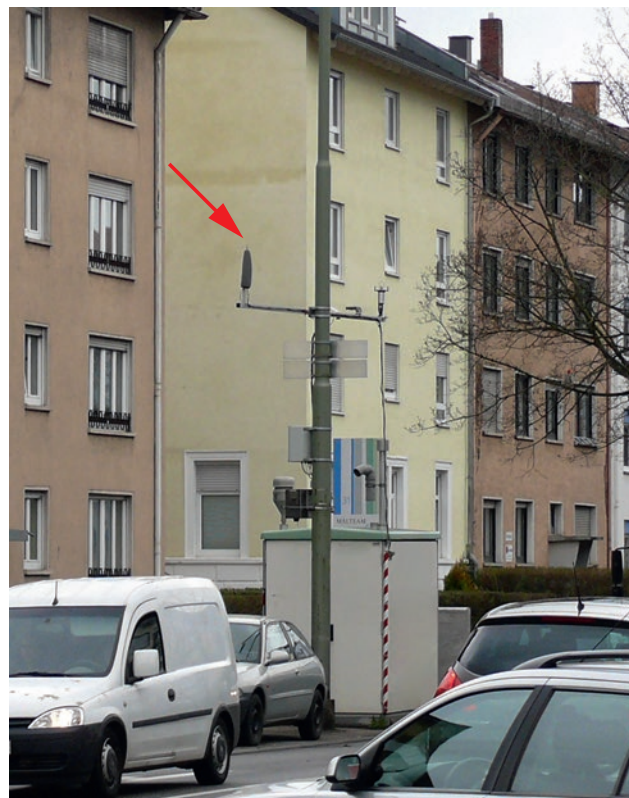
Abbildung 5.2-1: Messstation der LUBW zur Erfassung von Straßenverkehrslärm in Karlsruhe, Reinhold-Frank-Straße. Der Pfeil zeigt die Lage des Mikrofons, im Hintergrund Wohnbebauung. Foto: LUBW
