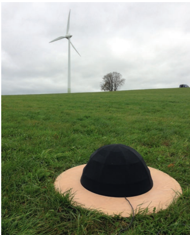
Abbildung 4.3-1: Messpunkt MP1 mit Mikrophon, schallharter Platte und doppeltem Windschirm. Im Hintergrund die 120 m entfernte Windenergieanlage WEA 2. Foto: Fa. Wölfel.
